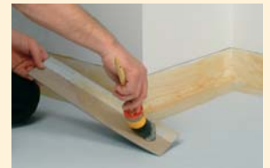
Boden und Wand bis zur Markierung mit Kontaktklebstoff einstreichen.
