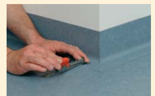
Überstehenden Belagsstreifen abschneiden.
